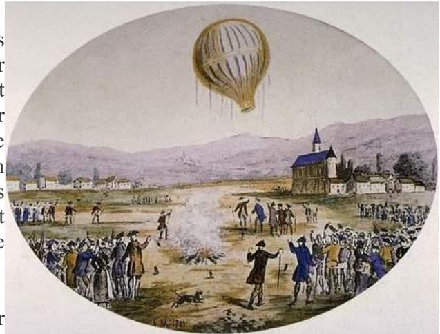
Le premier vol officiel de leur ballon à air chaud s'est déroulé, le 4 juin 1783, sur la place des Cordeliers à Annonay en Ardèche. Leur prototype de montgolfière : fait de toile et de papier, gonflé avec de l'air chaud, de 12 mètres de diamètre et d'un volume d'environ 800 à 900 m<sup>3</sup>, s'élève à près de 1000 mètres et parcourt 2 kilomètres en 10 minutes avant de retomber dans une vigne, sur la paroisse de Davézieux.
