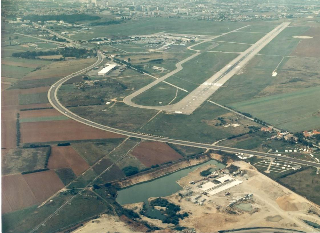
En 1975, la surface revêtue totale de la piste est de 157.620 m<sup>2</sup>, et celle des voies de circulation de 78.762 m<sup>2</sup>. Une bande de sécurité, train rentré, située à l'est de la piste principale, atteint une surface de 72.000 m<sup>2</sup>.
